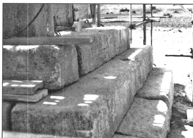
جفت گیری و نصب قطعات سکوی غربی و شمالی آرامگاه
