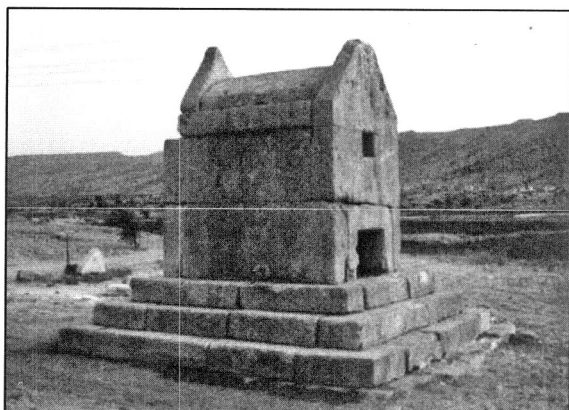
نمای شمال شرقی بعد از مرمت
